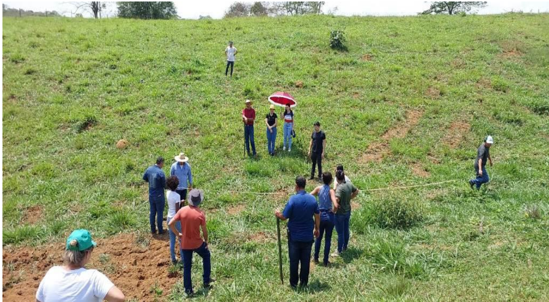
Figura 8. Escolha do local e início da demarcação para a construção de uma barraginha. Fonte: Acervo Márcio Menon, 2024.
