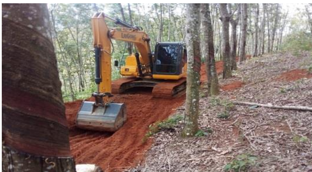
Figura 20. Construção de cochinchos em curva de nível em plantio de seringueira. Fonte: Acervo Márcio Menon, 2024.
