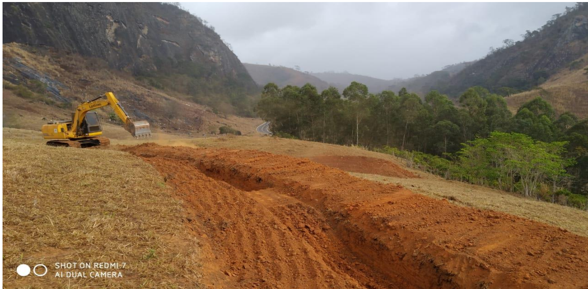
Figura 10. Cochinho com travesseiros em construção em área de pastagem degradada. Fonte: Acervo Márcio Menon, 2024.
