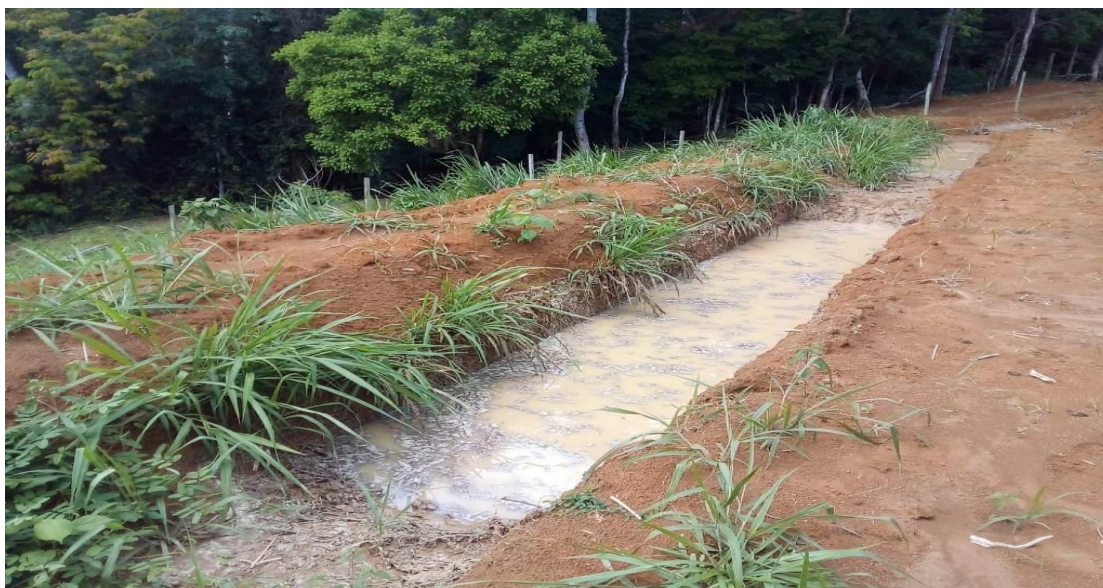
Figura 11. Cochinho com travesseiros: água de chuva armazenada. Fonte: Acervo Márcio Menon, 2024.
