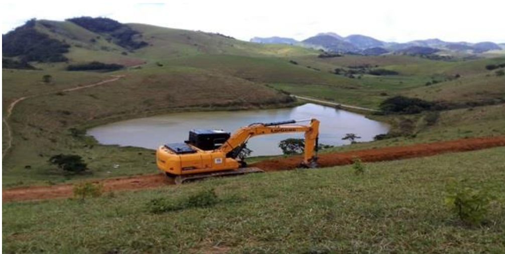
Figura 27. Retroescavadeira na construção do CNC. Fonte: Acervo Márcio Menon, 2024.
