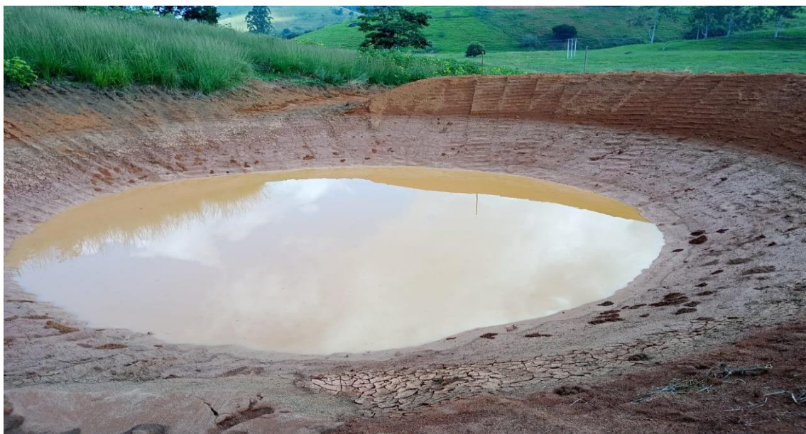
Figura 9. Barraginha recém-construída: primeira carga e recarga de água de chuva em área de pastagem. Fonte: Acervo Márcio Menon, 2024.
