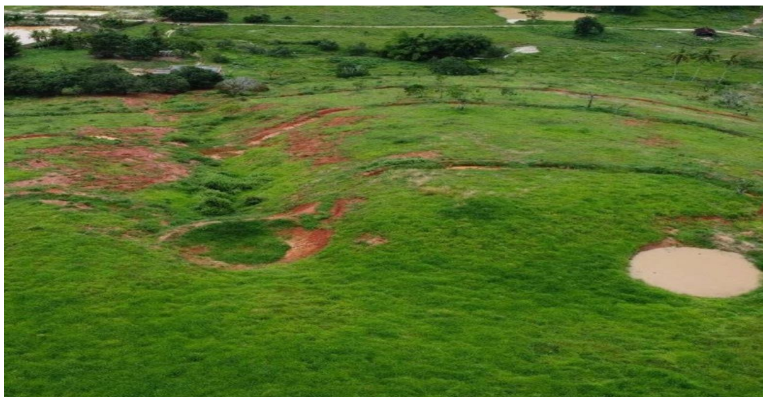
Figura 3. Barraginhas e cochinchos em curva de nível com água de chuva armazenada: recarga de aquíferos favorecida. Fonte: Acervo Márcio Menon, 2024.
