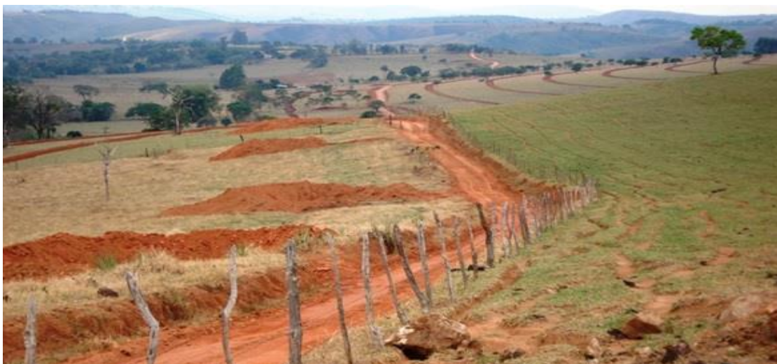
Figura 25. Barraginhas e cochinhos construídos de forma dispersa em pastagens, lavouras ou beiras de estrada, seguindo a topografia. Fonte: Márcio Menon, 2024.
