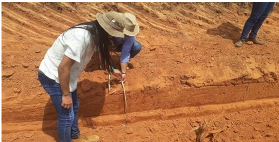
Figura 28. Controle das dimensões do CNC. Fonte: Acervo Maurício Novaes, 2023.
