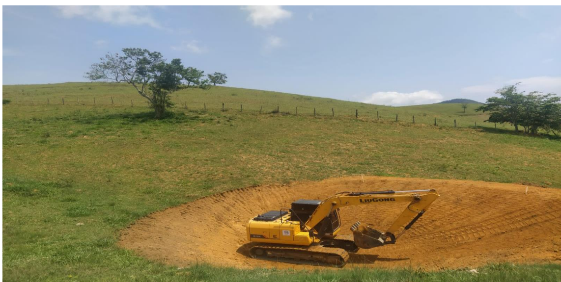
Figura 9. Construção de uma barraginha em parceria com a Prefeitura de Atílio Vivácqua. Fonte: Acervo Maurício Novaes, 2023.
