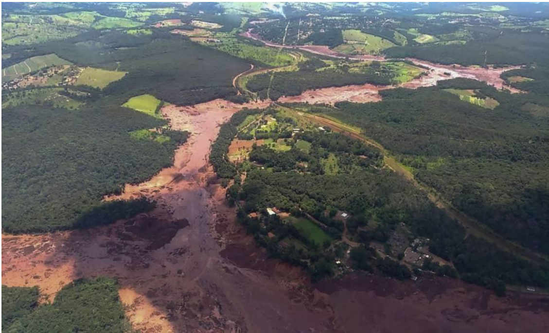
Figura 1. Degradação ambiental causada pelo modelo de desenvolvimento pós-revolução industrial: rompimento barragem Brumadinho, MG. Fonte: EL PAIS, 2021.
