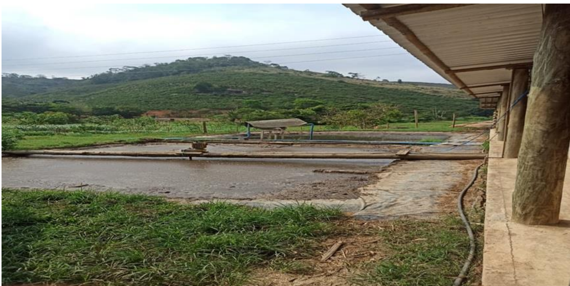
Figura 11. Aproveitamento de efluente da bovinocultura anteriormente lançado em corpo hídrico, Atilio Vivácqua, ES. Fonte: Acervo Maurício Novaes, 2023.
