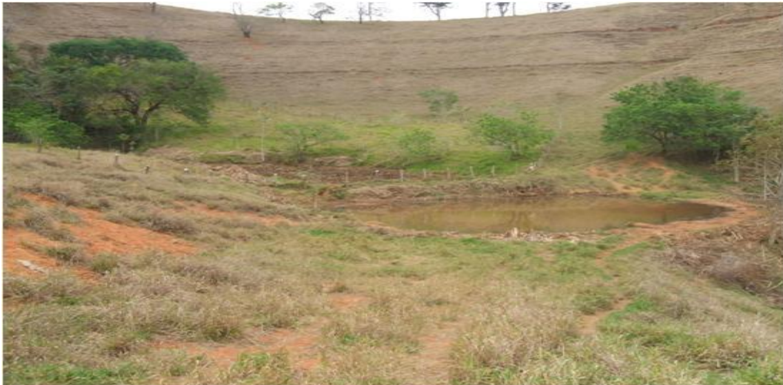
Figura 7. Início de procedimentos de recuperação de nascente no CEFET/Rio Pomba, MG. Fonte: Acervo Maurício Novaes, 2006.
