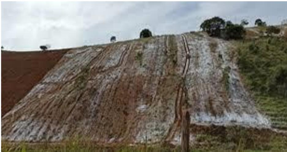
**Figura 6.** Rochagem como corretivo de acidez e fertilizante em procedimento de recuperação de áreas degradadas. Souza, 2023.
