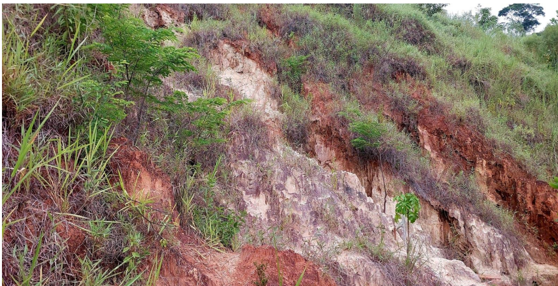
Figura 10. Voçoroca em processo de recuperação com a intervenção de cochinhos na parte superior e revegetação dos taludes, Sítio Jaqueira Agroecologia, Alegre, ES. Fonte: Acervo Maurício Novaes, 2024.
