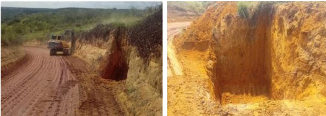
**Figuras 21 e 22.** Caixas secas. Fonte: Portal Mantena, MG, 2019.
