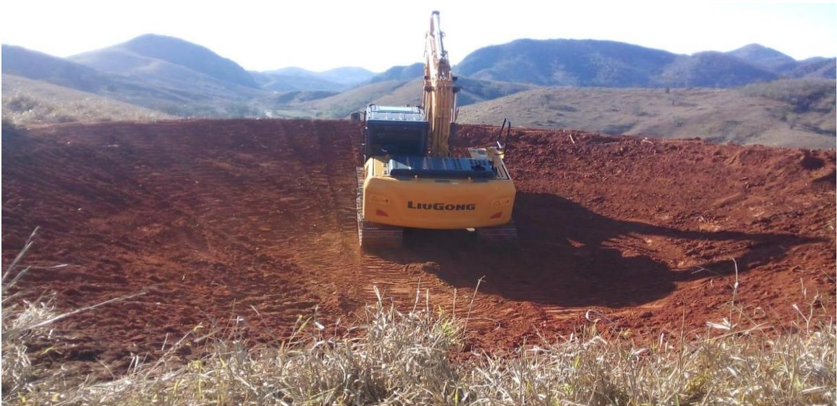
**Figura 13.** Área de pastagem degradada em Atílio Vivácqua recebendo intervenção e construção de barraginha. Fonte: Acervo Maurício Novaes, 2022.
