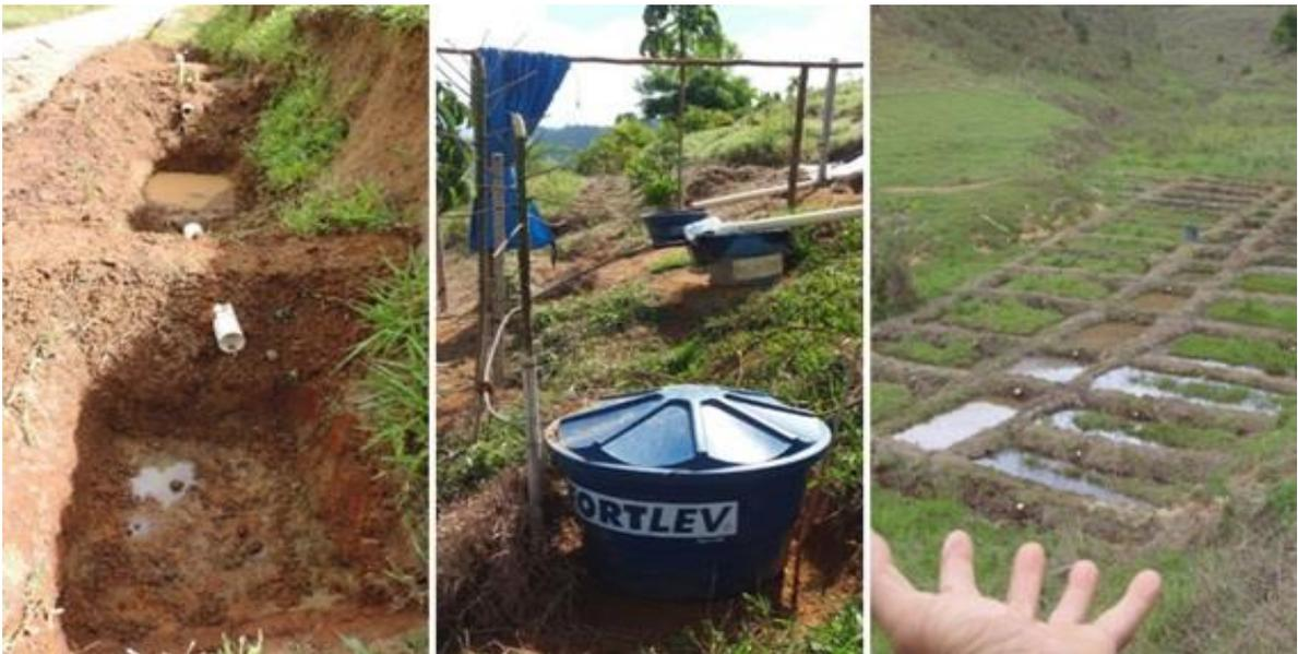
**Figuras 18, 19 e 20.** A) Caixas-secas sequenciais construídas em estrada rural. B) Caça-chuva de cumeeira no Sítio Jaqueira Agroecologia. C) Caixas-cheias preparadas para o plantio de arroz. Fonte: Arquivo PLANT’ÁGUA, 2015 e 2022.
