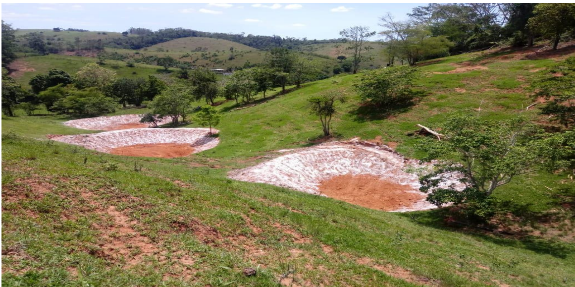
Figura 5. Barraginhas em sequência em área de pastagem - Atílio Vivácqua, ES. Fonte: Acervo Marlon Peçanha (2020).
