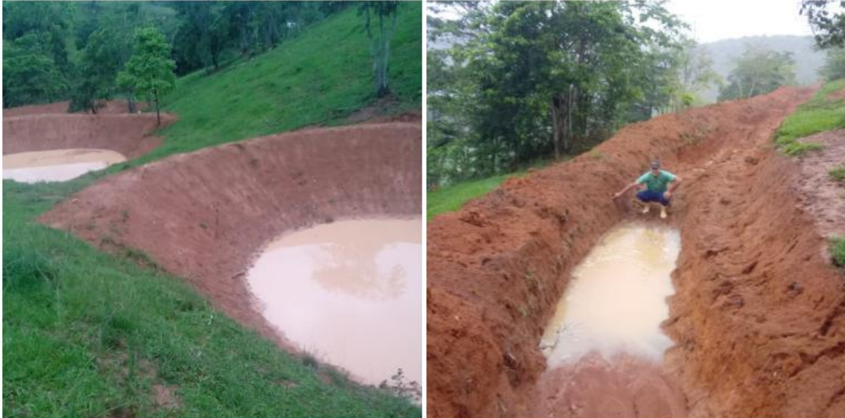
Figura 9. Barraginhas e cochinchos em consórcio implementados e exercendo sua função em área de pastagens - Atílio Vivácqua/ES. Fonte: Acervo Marlon Peçanha (2020).
