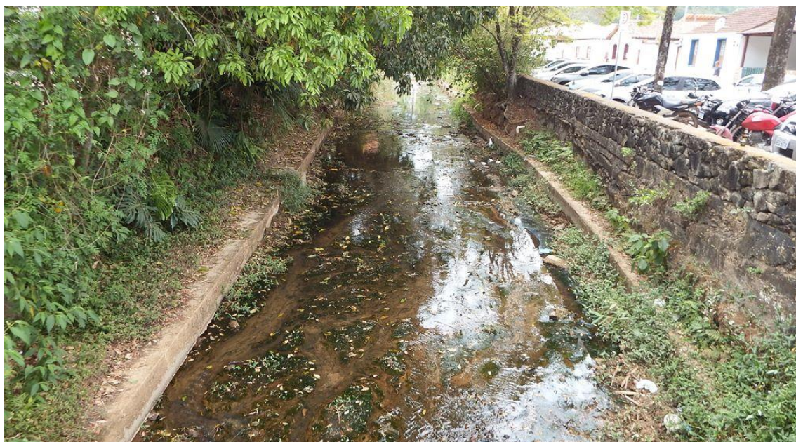
Figura 18. Trecho de afluente do rio das Mortes em Tiradentes, MG, recoberto com concreto: perda da biodiversidade. Fonte: Acervo Maurício Novaes (2018).
