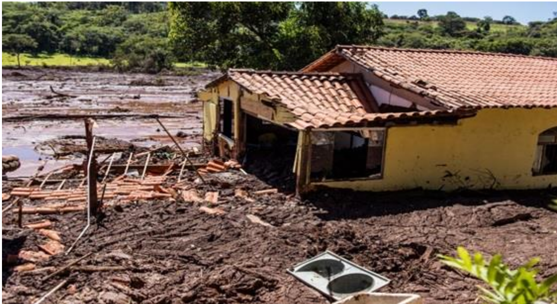
Figura 2. Rompimento da barragem de Brumadinho. Fonte: Mídia Ninja (2019).
