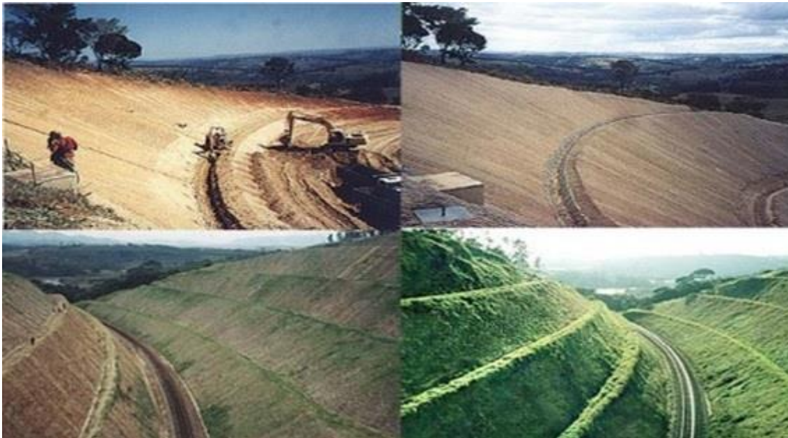
Figura 4. Talude vegetado com leguminosas, gramíneas e espécies nativas. Fonte: Pereira (2018).
