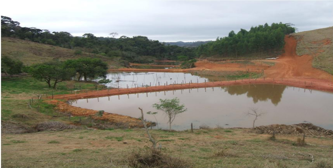
Figura 5. Construção de lagoas e barragens no IF Sudeste de Minas campus Rio Pomba: planejamento e análise prévia dos IA diretos e indiretos da obra em execução. Fonte: Arquivo Maurício Novaes (2011).
