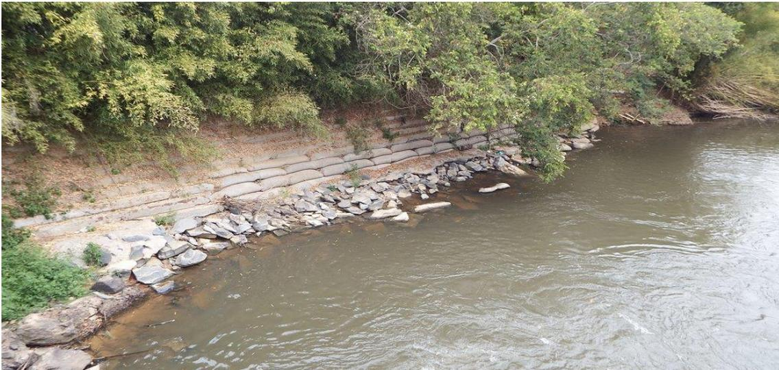
**Figura 13.** Margem de rio em Tiradentes, MG, com proteção de sacos com mistura de *solo-cimento* e água. Fonte: Arquivo Maurício Novaes (2018).
