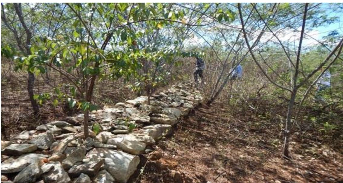
**Figura 23.** Barragem de contenção de sedimentos e cordões de pedras. Fonte: Agência EcoNordeste (2020).
