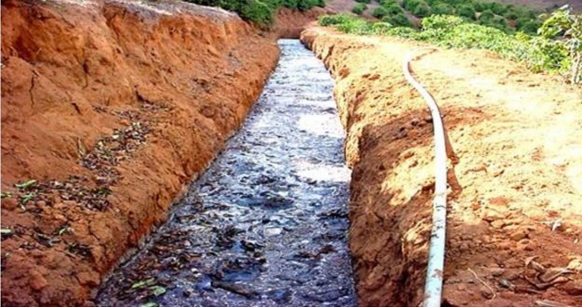
**Figura 16.** Infiltração de efluentes por percolação em “Cochinhos”. Fonte: Arquivo pessoal (2007).
