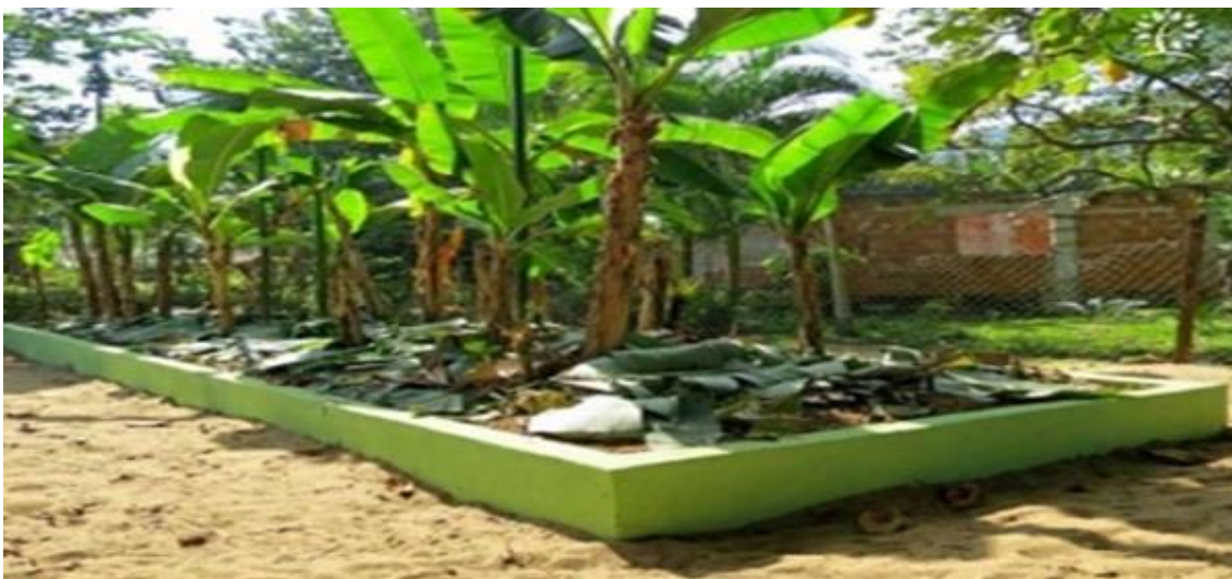
Figura 4. Saneamento ecológico com o “Círculo de Bananeiras”: bacia de evapotranspiração construída em comunidade caiçara de Paraty-RJ pelo “Projeto Observatório de Territórios Saudáveis e Sustentáveis da Bocaina”. Fonte: Figueiredo; Santos; Tonetti (2018).
