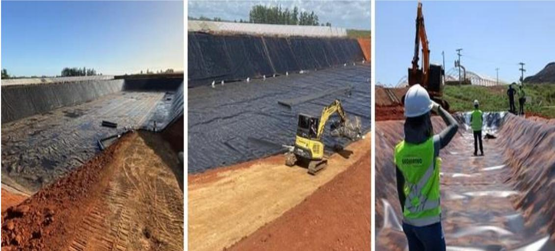
**Figura 5.** Projeto de recuperação de lagoas de tratamento de efluentes com mantas geossintéticas. Fonte: <https://www.geossintec.com.br/geossinteticos-na-recupera-ção-de-áreas-degradadas-e-contaminadas>.
