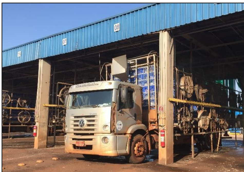
Figura 2. Área de espera para caminhões com a presença de ventiladores. Fonte: SILVA, P. R. M. (2016).
