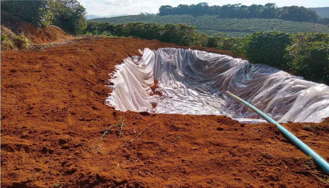
**Figura 11.** Barraginha (lago de múltiplo uso) com fundo coberto para aproveitamento da água para irrigação da lavoura. Fonte: [www.tratofeito.com.br/ibatiba](http://www.tratofeito.com.br/ibatiba) (2021).
