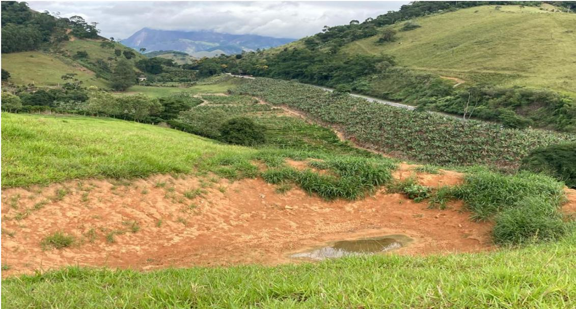
**Figura 9.** Barraginha em área de pastagem visando a retenção de água para recarga de aquífero e o favorecimento de lavouras à montante em Atílio Vivácqua, ES. Fonte: Carlos Renato Sant’Anna (2022).
